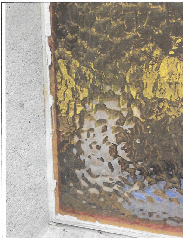
Contrôle des fenêtres et réparation des mastic.
